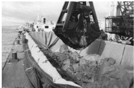
Figure 6. 지오콘테이너 바지선 설치사진.
